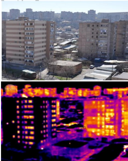
Նկար 10.5. ՄԱԶԾ/ԳԷՖ և քաղաքապետարանի համատեղ պիլոտային նախագծով ջերմասարդիականացված շենքը գերեկային և ինֆրակարմիր տեսքով և շենքի էներգետիկ բնութագրերը ամփոփող էներգասարդյունավետության սերտիֆիկատ
